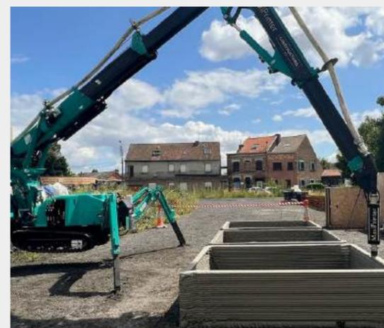
Der Mobile 3D-Betondruckroboter „MaxiPrinter“
