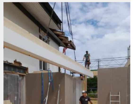
Versetzen der vorgefertigten Holzelemente
