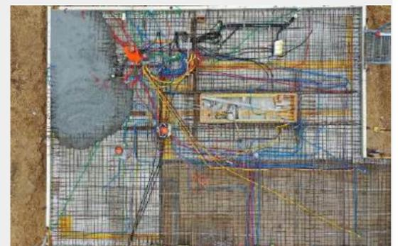
Bodenplatte betonieren Kranbeton
