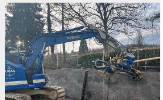
Nägel bohren in einer Gunitwand
