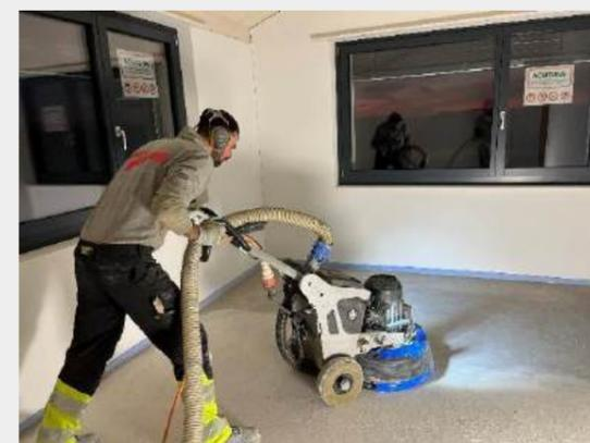
Oberflächenbearbeitung mit Schleifmaschine
