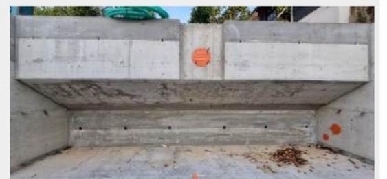
Detailarbeit bei Pool mit SCC-Beton
