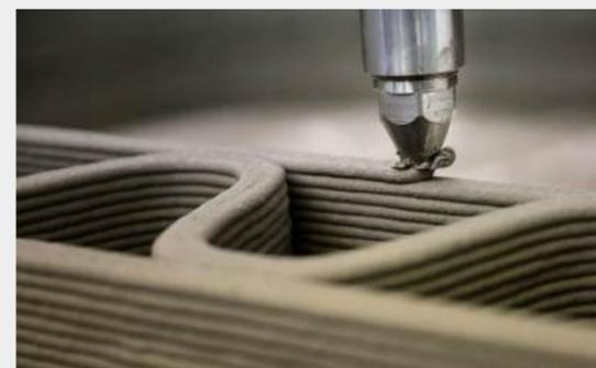
Druckdüse beim schichtweisen Auftrag
