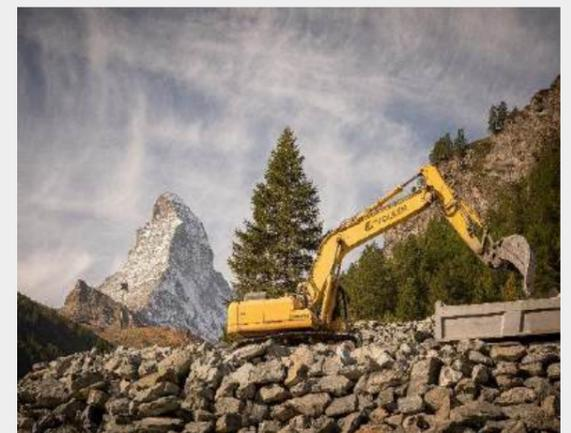
Erstellung des Aushubs für das Wasserreservoir
