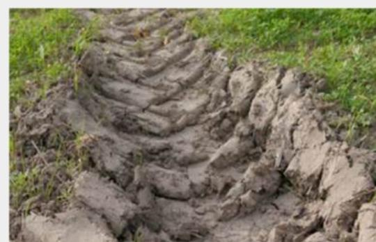
Schaden in einer Grünfläche durch das Befahren mit Pneufahrzeugen bei einem ungenügend tragfähigem Untergrund.
