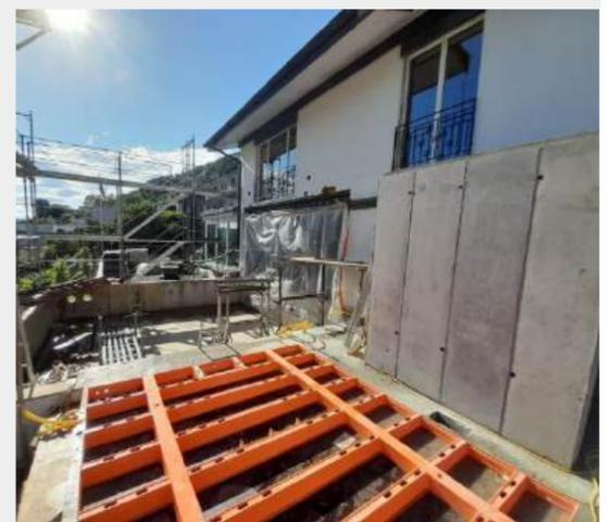
Ortbetonbauweise des UG und vom Liftschacht
